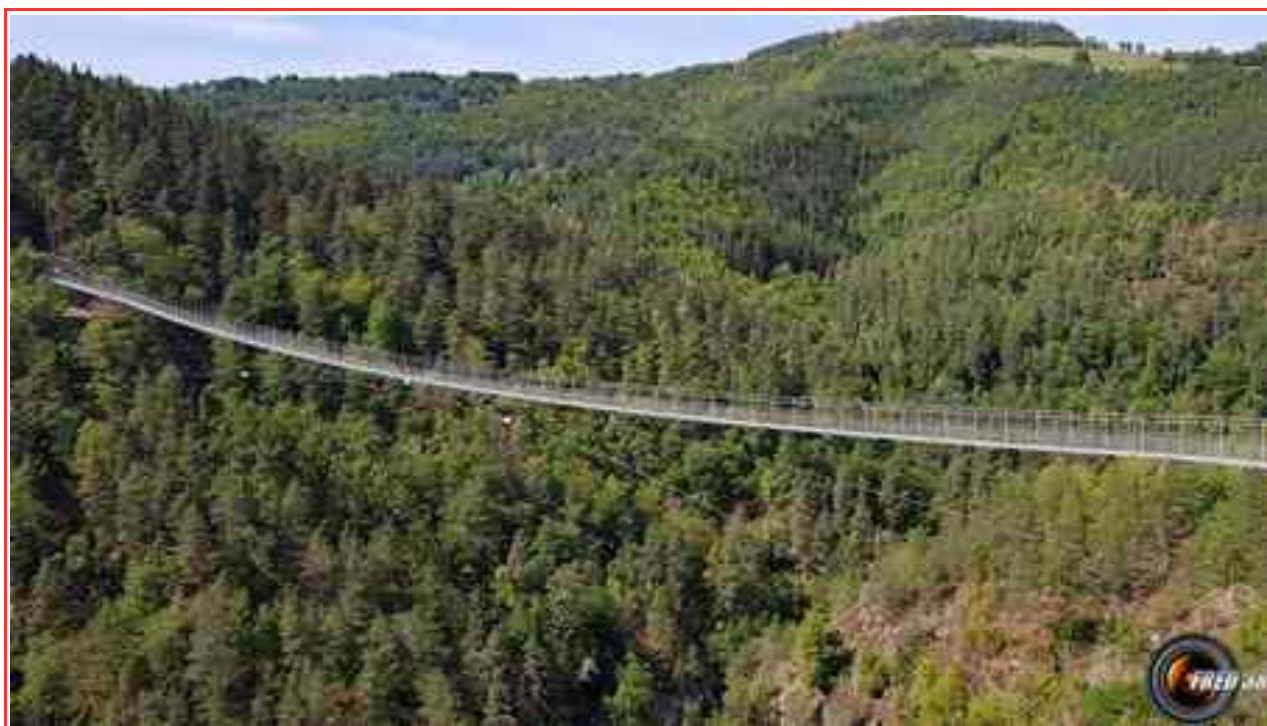
Vue du belvédère.
