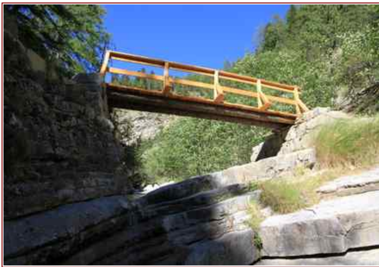
La passerelle à la fin des gorges
