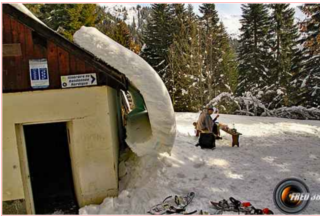
Le chalet-refuge de la Combe des Filles.
