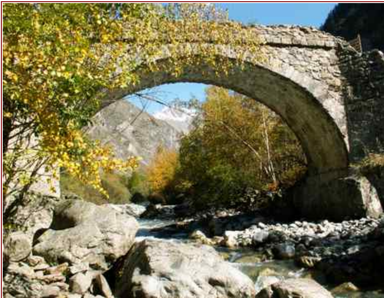
La Severaisse au niveau du Casset
